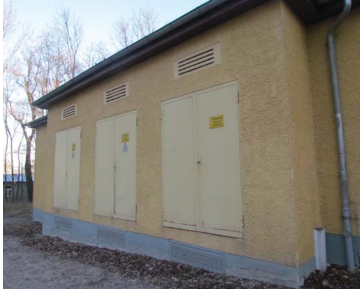
Abb. 31 Ansicht Transformatorstation I, 2016
