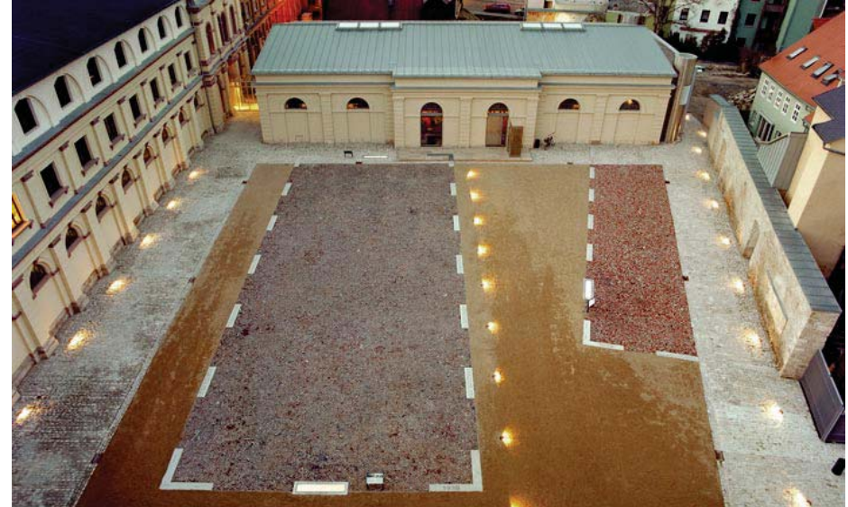
Abb. 8 Innenhof mit ehemaligem Barackenstandort
