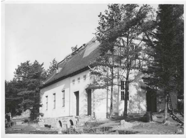
Abb. 22 Druckerhöhung Daasdorf kurz vor der Fertigstellung, 1943
