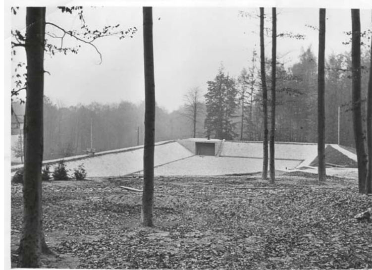
Abb. 10 Fertiggestellte Zisterne beim Hochbehälter, um 1938
