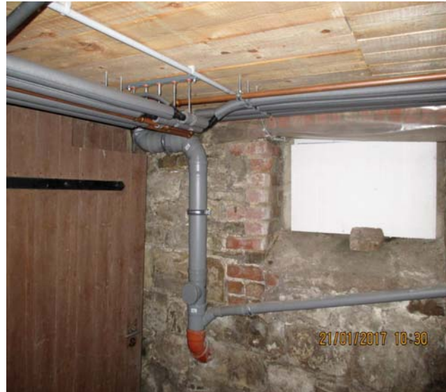
Abb. 43 Verbaute Steine im Keller, 2017
