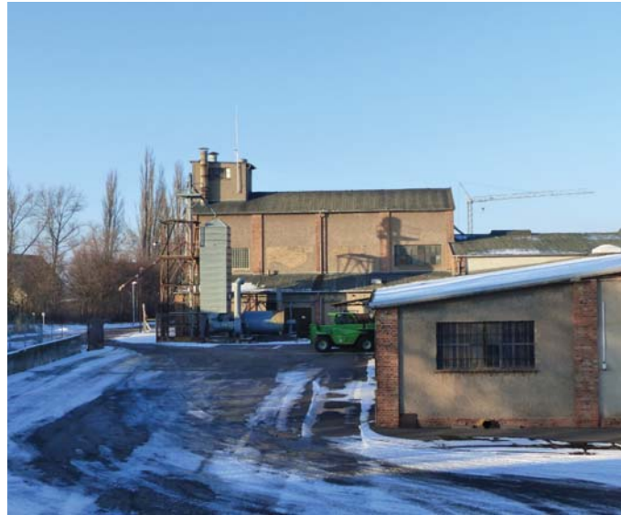
Abb. 17 Der Betriebshof ist in seiner ursprünglichen Form noch gut nachvollziehbar.
