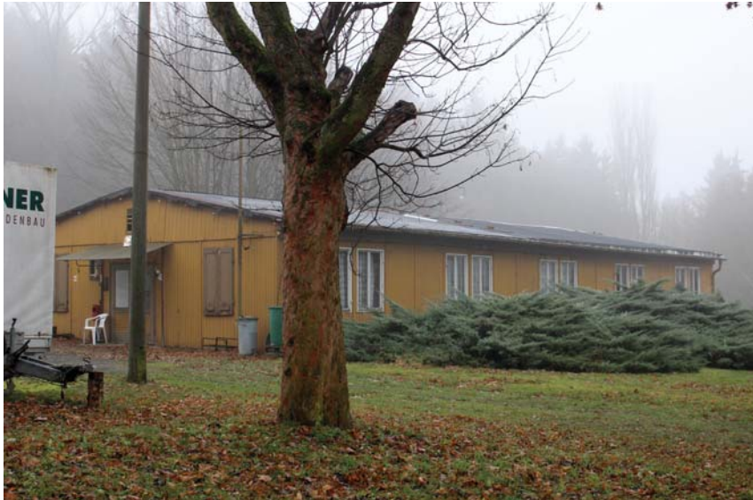
Abb. 20 Holzbaracke von Norden, 2016
