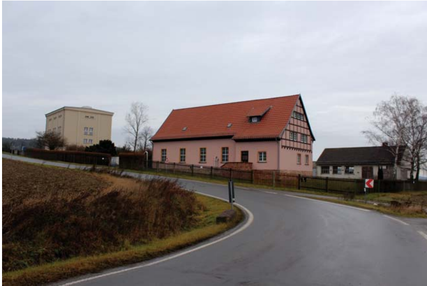
Abb. 26 Gebäudeensemble der Wasseraufbereitungsanlage Tiefengruben, 2016
