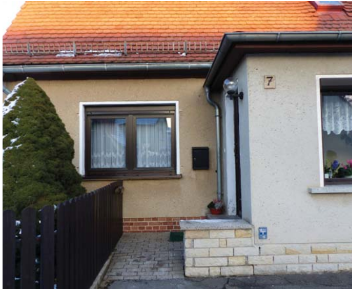
Abb. 16 Von außen ist gut erkennbar, welcher Gebäudeteil nachträglich ergänzt wurde.
