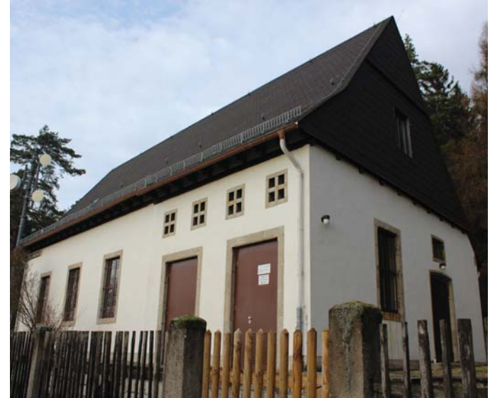
Abb. 25 Heutiger Zustand der Druckerhöhungsanlage, 2016
