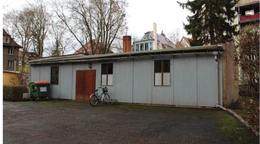
Abb. 19 Ansicht von Südosten, 2016
