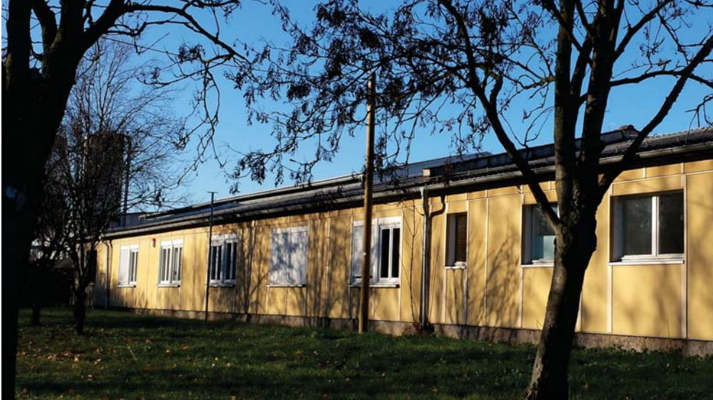
Abb. 22 Ansicht von Südosten, 2016
