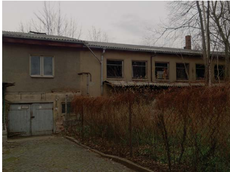
Abb. 13 altes Gebäude hinter dem Kühlhaus
