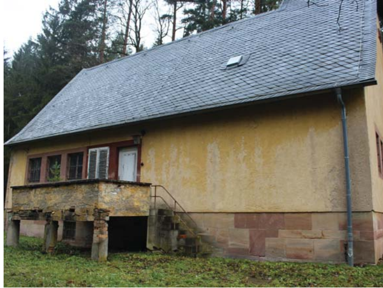
Abb. 20 Brunnenhaus Tonndorf II, 2016
