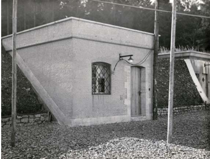
Abb. 11 Steuerungsraum des Hochbehälters kurz nach der Fertigstellung, um 1938
