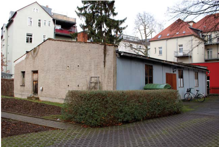
Abb. 16 Ansicht der Baracke von Südwesten, 2016
