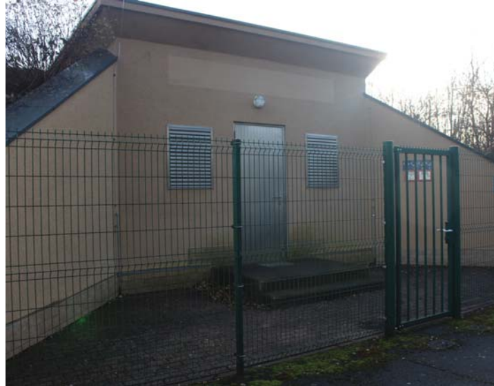
Abb. 12 Steuerungsraum des Hochbehälters, 2016
