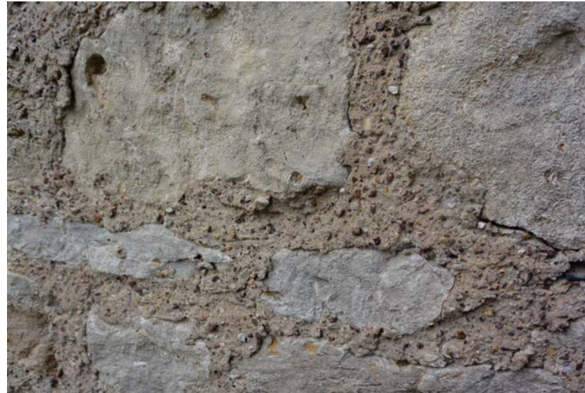
Abb. 46 Verbaute Steine im Sockelbereich, Nahaufnahme, 2016
