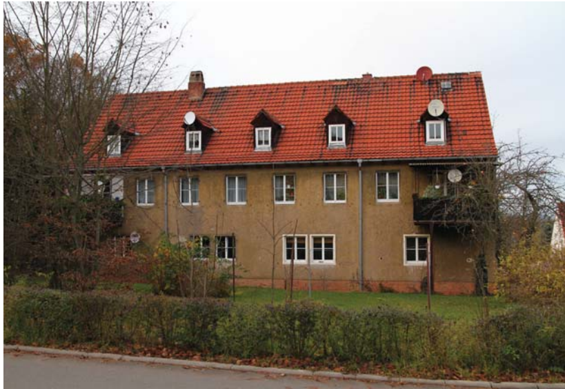
Abb. 19 Rückfassade des nördlichen Mietshauses
