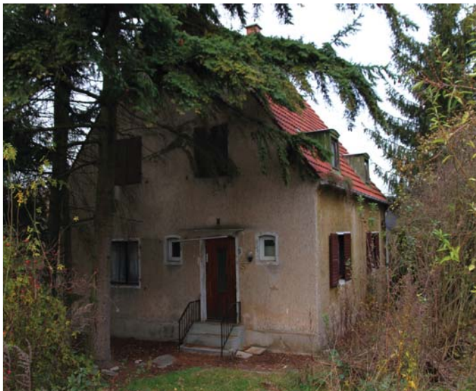
Abb. 22 Einzelhaus in weitestgehend bauzeitlichem Zustand
