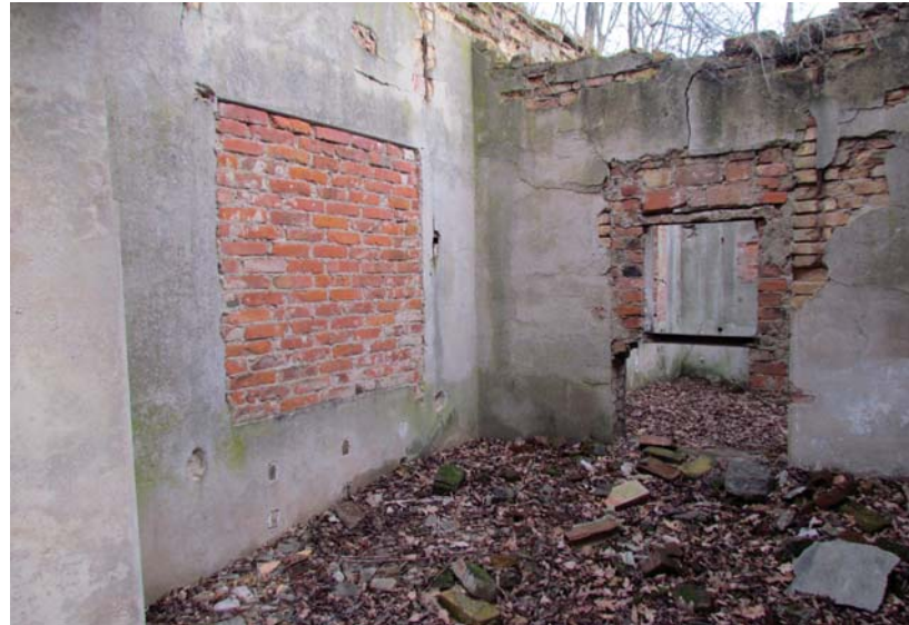
Abb. 34 Überreste der Transformatorstation II, 2016
