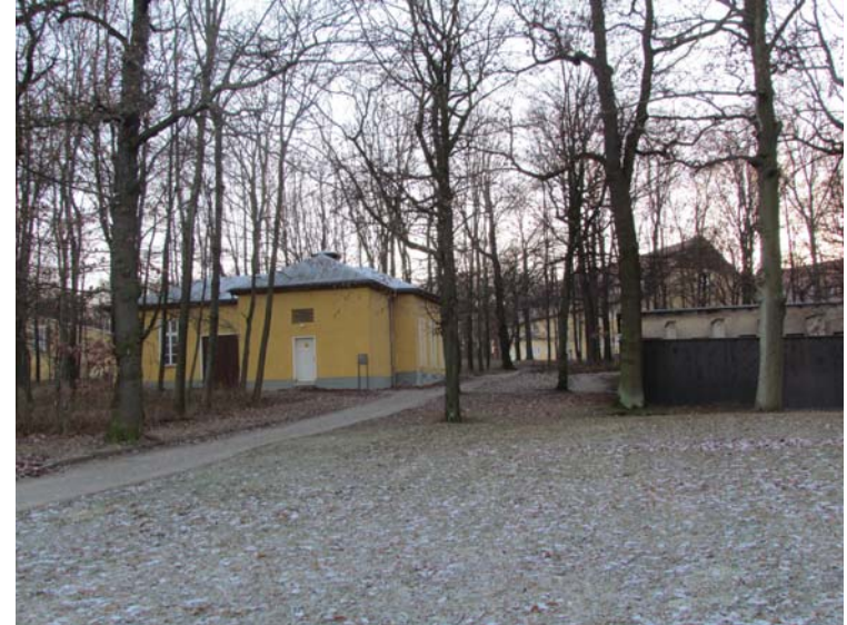
Abb. 32 Umfeld der Transformatorstation I in der Gedenkstätte Buchenwald, 2016
